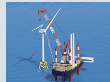
④風車設置イメージ(SEP船)
